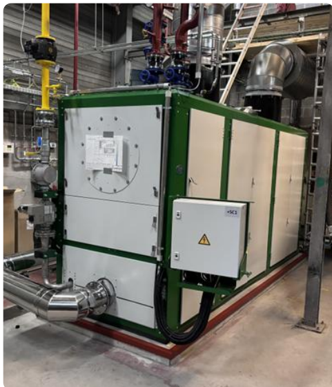
Afbeelding: de in 2024 geïnstalleerde warmtekrachtkoppelingseenheid
