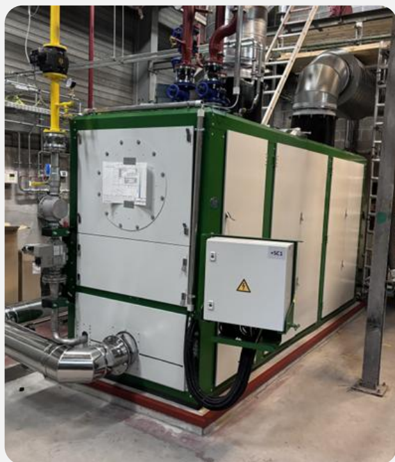
L'image ci-dessus illustre l'unité de cogénération installée en 2024
